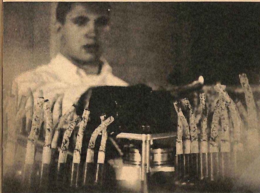
ΕΚΑΤΟ ΣΙΓΑΡΕΤΑ ταυτόχρονα «καπνίζει» ἡ μηχανή. 'Ο κα- πνὸς τους περισυλλέγεται κ' ὑποβάλλεται σὲ διάφορες ἀναλύσεις
