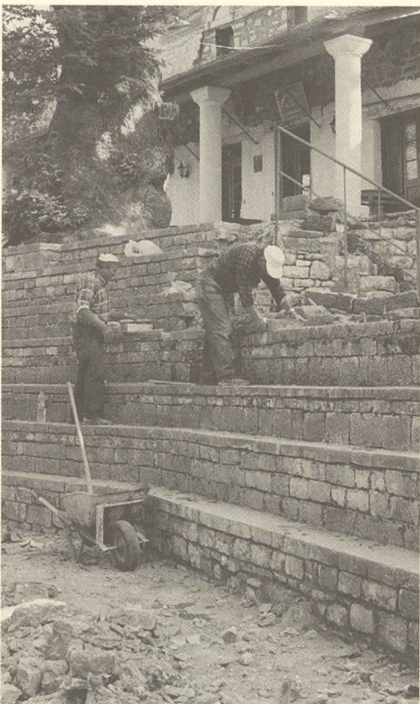
Η αποκατάσταση των βαθμίδων της Πλατείας.
