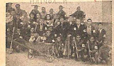
Έρυθροσταυρίται του Δημ. Σχολείου Άδάμαντος Μήλου Ισοπεδώνουν την πλατεία του χωριού.
