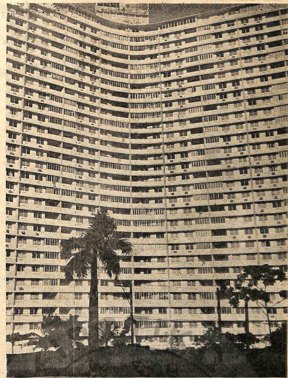
Ένα υπερμοντέρνο κτίριο στην 'Αβάνα, η οποία έχει ηλικία μόλις 400 ετών.
