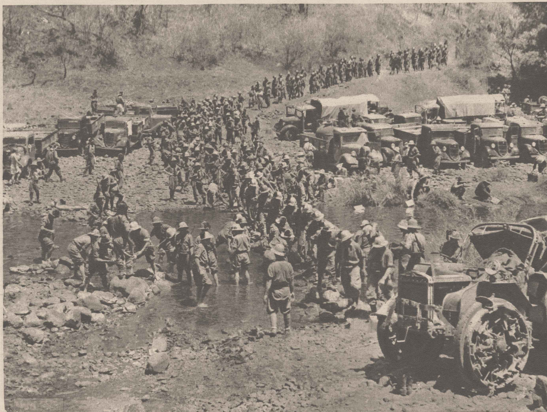
ΙΤΑΛΙΚΗ ΦΑΛΑΓΞ στρατοπεδεύουσα εἰς τὰ περὶ τοῦ Γκόντα, πλησίον πηγῆς ὕδατος. Αἱ διαρκεῖς ἐπιθετικαὶ ἰταλικά ἐξοδοί, ἔκαμαν τὸν ἐχθρὸν νὰ ἐννοήσῃ, τὴν ἀκράδαντον θέλησιν ἀντιστάσεως τῶν γενναίων φασιστῶν πολεμιστῶν. Ὑπέμειναν κάθε φύσεως θυσίαν, διὰ νὰ ὑπερασπίσων τὴν νῆσον αὐτὴν τῆς πατρίδος, εἰς τὴν αὐτοκρατορικὴν γῆν.
