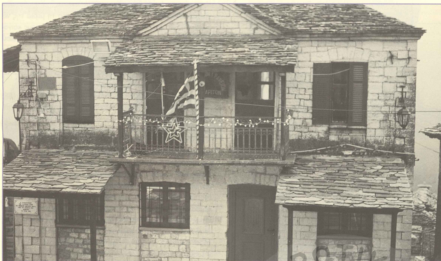
Το παλιό κοινοτικό γραφείο, δείγμα χαρακτηριστικής καλαρρυτινής αρχιτεκτονικής.
