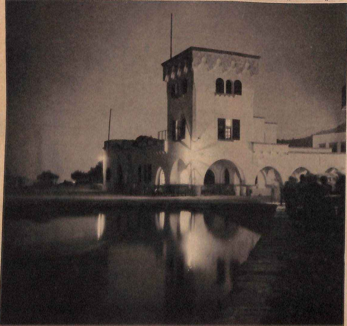
ΤΟ ΚΤΙΡΙΟΝ ΟΠΟΥ ΕΣΤΕΓΑΖΕΤΟ ΤΟ ΔΙΟΙΚΗΤΗΡΙΟΝ, ἐπὶ ἰταλοκρατίας, χρησιμοποιεῖται ἀπὸ τὴν ἐποχὴ τῆς ἀπελευθερώσεως τῆς νήσου, ὡς τελωνεῖον καὶ γιὰ τὴν στέγασιν ὄλων τῶν ὑπολοίπων δημοσίων ὑπηρεσιῶν.
