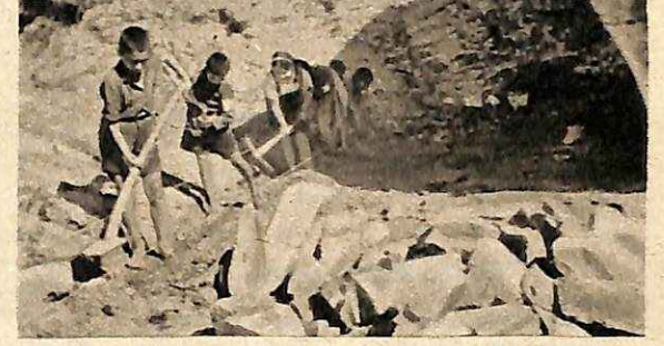
Ε.Ε.Σ.Ν. Δημ. Σχολ. Μέσας Ποτάμους Λασιθίου. Διάνοιξις θεμελίων πρὸς ἀνέγερσιν μανδρωτοῦ τοῦ σχολείου. Juniors of Elem. School Messapotamion Lassithion. Making foundations for building the school wall.
