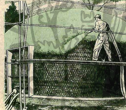
Νὰ πῶς ἐπιστρώνεται με τσιμέντο ἕνα «σπίτι-μπαλόνι», με τὴ βοήθεια ἐνὸς ἐιδικ- κοῦ «πιστολιοῦ».
