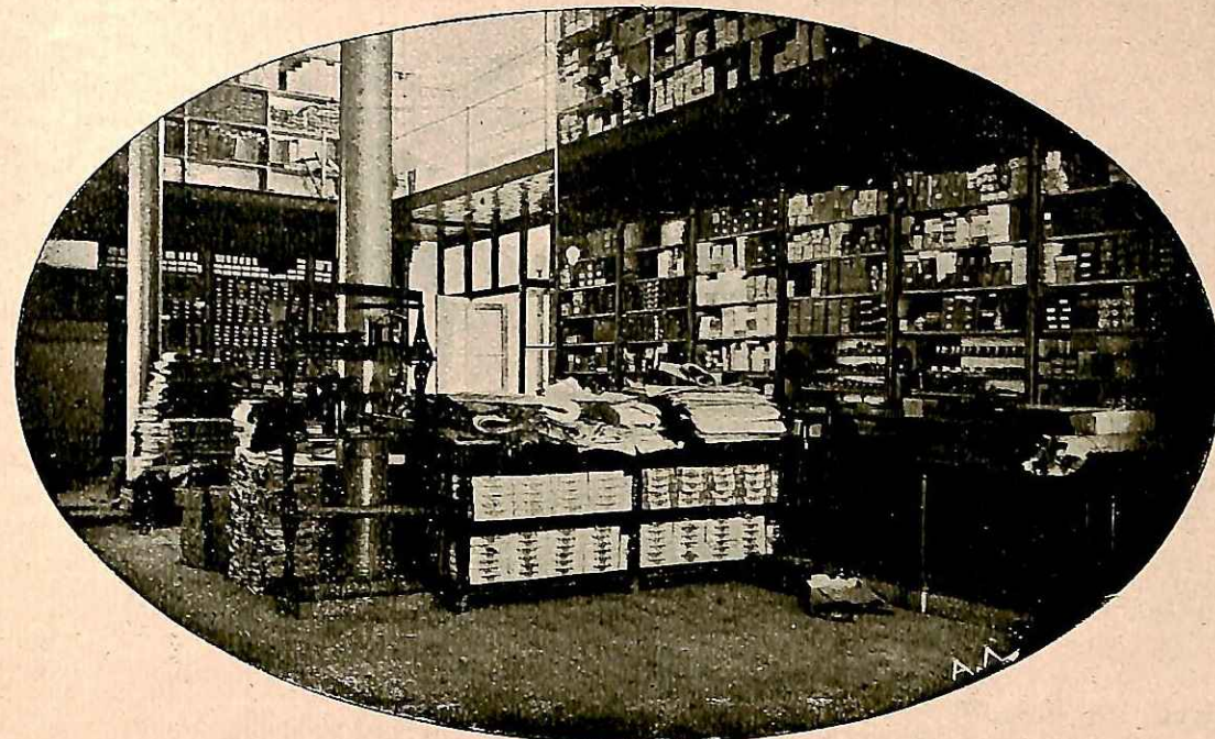
ΣΤΟΑ ΤΟΥ ΕΡΓΟΣΤΑΣΙΟΥ ΤΕΡΖΟΠΟΥΛΟΥ
