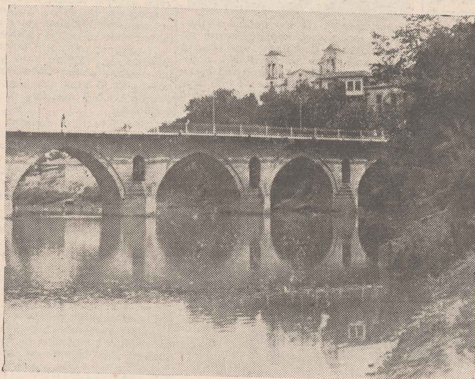
Η γέφυρα τού Πηνειού στό 'Αλκαζάρ τής Λαρίσης
