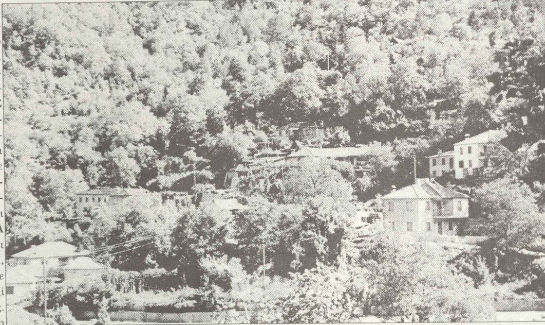
Βρυσσχώρι: Μερική άποψη του Πάνω Μαχαλά
