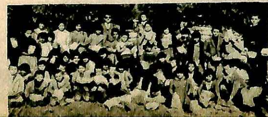
Ε.Σ.Ν. Δημ. Σχολ. Τσαμαντᾶ Φιλιατῶν βοηθοῦντες τὴν ἀνοικοδόμησιν τοῦ σχολείου. Juniors of Elem. school Tsamanta Philiates helping in the reconstruction of their school.
