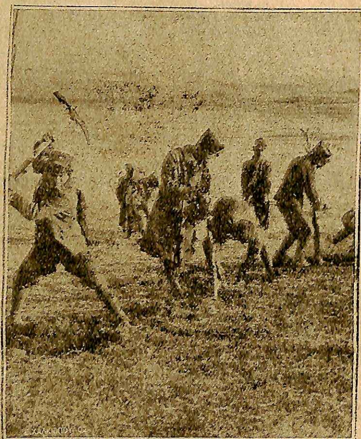
ΑΠΟ ΤΟ ΜΕΤΩΠΟΝ.— Μετά την κατάληψιν, κατασκευή προχείρων συρματοπλεγμάτων.
