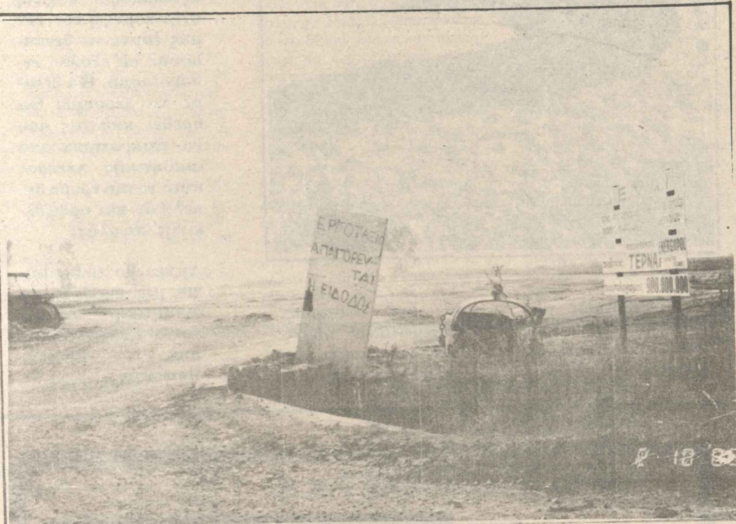
Η πινακίδα στο χώρο που πρόκειται να κατασκευαστεί το εργοστάσιο, με προϋπολογισμό 900.000.000 δρχ.
