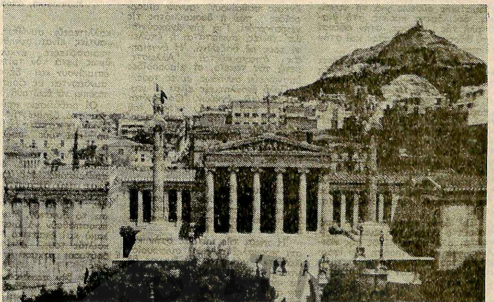
Τὸ μέγαρο τῆς Ἀκαδημίας μὲ τὸ βράχον τοῦ Λυκαβηττοῦ ἄνω δεξιᾶ.
