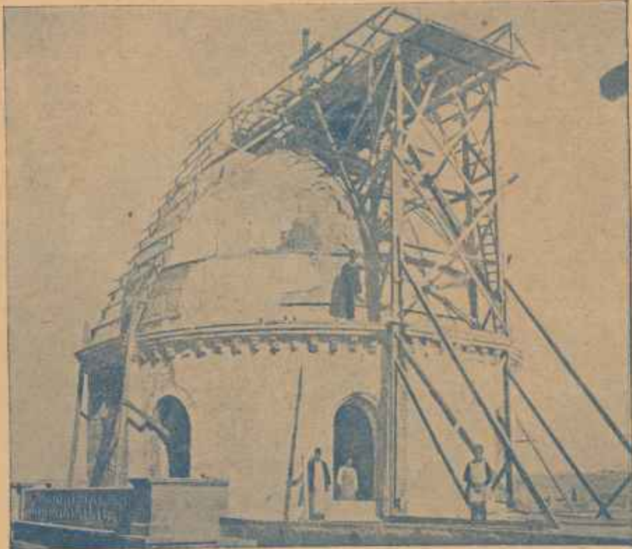
Ὁ ἐπισκευαζόμενος ἐξόλος τοῦ Παναγίου Τάφου ὁ ὁποῖος εἶχε ὑποστῇ μεγάλες βλάβες πρὸ τινων μηνῶν ἀπὸ ἑνὰ δυνατὸ σεισμό.
