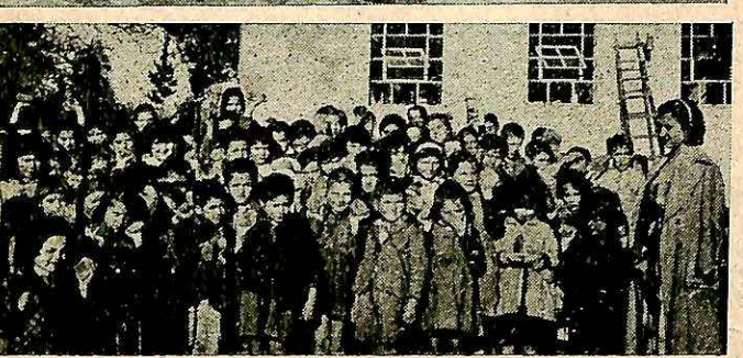
Ε.Σ.Ν. Δημ. Σχολ. Κάμπων Κυθωνίας Χανίων μεταφέρουν πέτρες γιὰ τὸ κτίσιμον ὑδατοδεξαμενῆς τοῦ Σχολείου Juniors of elem. school Kampe Chania Crete working for the reconstruction of their school
