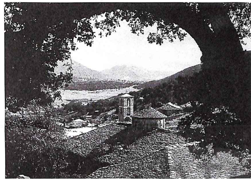
Κάτω Πεδινά Ζαγοριού (Σουδενά). Η στέγη του Αγίου Αθανασίου (1704).
