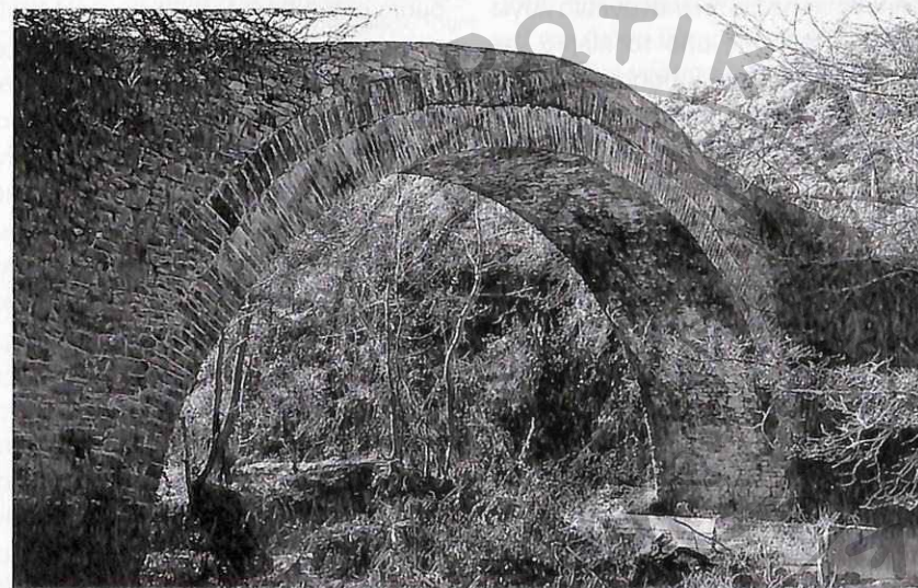
(Φωτ. 28-1) Η «γέφυρα Πεκλαρίου Μπούσης» πριν το 1999. Γενική ανάντις όψη. Φαίνεται καθαρά το λειψό βοηθητικό στεφάνι του τόξου. [Πηγή: «Τα πέτρινα γεφύρια της Ελλάδας», του Αργ. Δ. Δημητράκη, εκδόσεις Αδάμ, Αθήνα 1999, σελ. 62].
