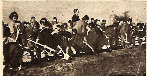
Ε.Ε.Ν. Δημ. Σχολ. Μουριάς Τρικάλων. 'Επισκευή κοινοτικής οδού. Juniors of Elem. School Mouria repairing a village road.
