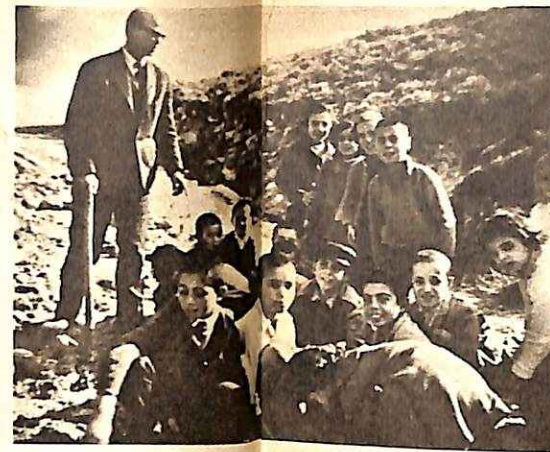
Ε.Ε.Ν. Δημ. Σχολ. Πισιδερου 'Ηρακλείου Κρήτης. 'Επισκευή κεντρικής οδού. Juniors of Elem. School Patsidero repairing the highway.
