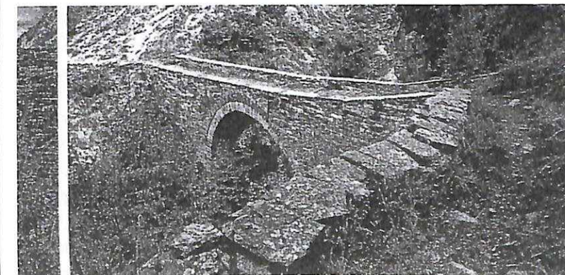
ΓΕΦΥΡΙ ΣΤΟ ΚΑΠΕΣΟΒΟ ΠΡΟΣ ΤΗ ΣΚΑΛΑ ΒΡΑΔΕΤΟΥ
