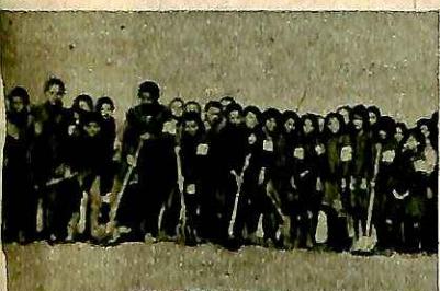
Ε.Σ.Ν. Δημ. Σχολ. Ράξης ↑ Τρικάλων διορθώνουν τὸν δρόμον τοῦ χωρίου. Juniors of Elem. school Raxi-Tricala repairing the village road.
