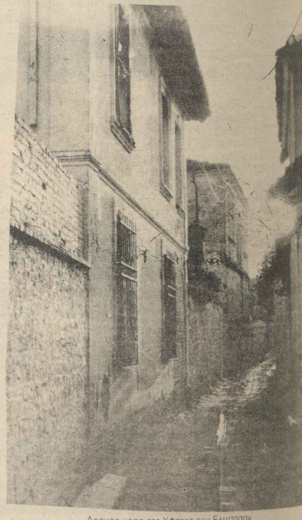
Δρόμος μέσα στο Κάστρο του Ελμπασάν
