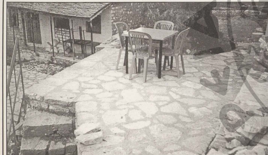
Αρχισε και συνεχίζεται η πλακοστρώση του χώρου εμπροσθεν του καφενείου ΑΡΑΕΤΟΥ
