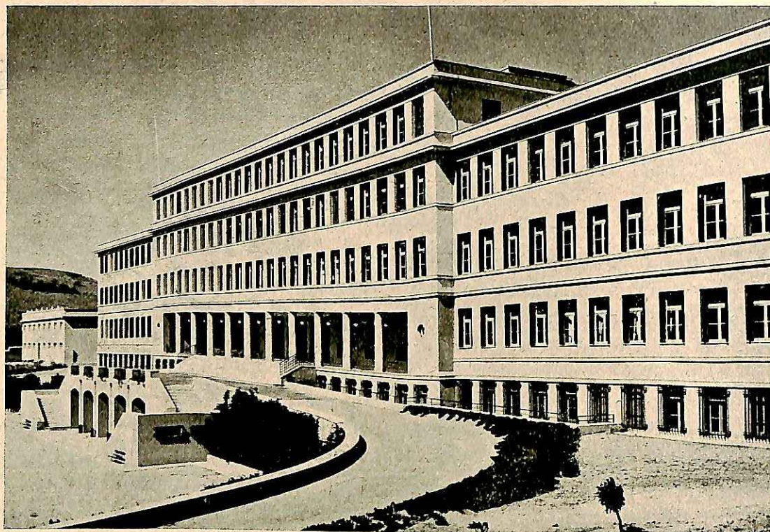
Μία άποψις τοῦ νέου κτιρίου τοῦ Ἀρσακείου εἰς τὸ Ψυχικόν.
