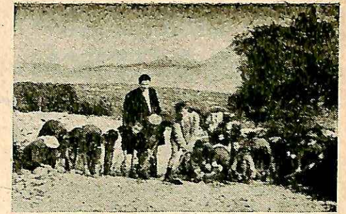
Ε.Ε.Σ.Ν. μαθηταί του Δημ. Σχολ. Πουλάτων Κεφαλληνίας έπισκευάζουν τμήμα της κοινοτικής οδού.
