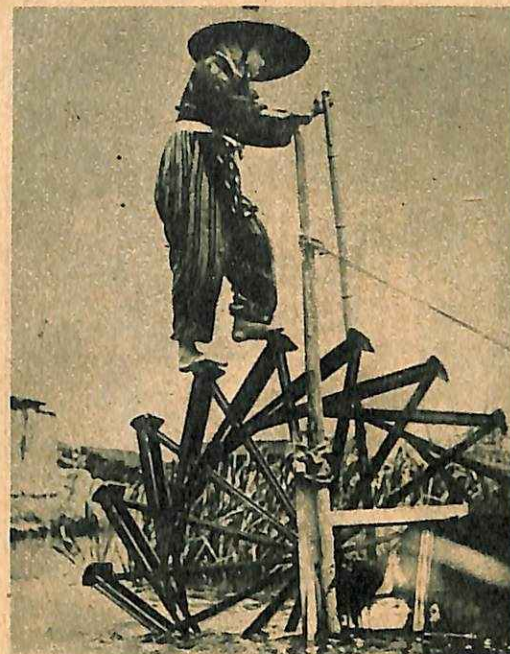
Σε πολλές επαρχίες της Ιαπωνίας εξακολουθούν ακόμα να χρησιμοποιούνται παλαιότερες μέθοδοι καλλιέργειας, όπως ο αρχαίος αυτός τροχός για το πότισμα του ρυζιού, που τον κινεί με τα πόδια της μιά χωρική, με την περιεργή ενδυμασία της.
