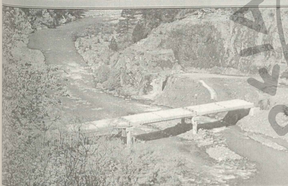
Απρίλιος 2001: Αποψη της κατασκευαζόμενης νέας γέφυρας στον ποταμό ΑΩΟ. ΦΩΤΟ: ΑΝΑΣΤΑΣΙΟΣ Γ. ΤΣΙΟΜΙΔΗΣ
