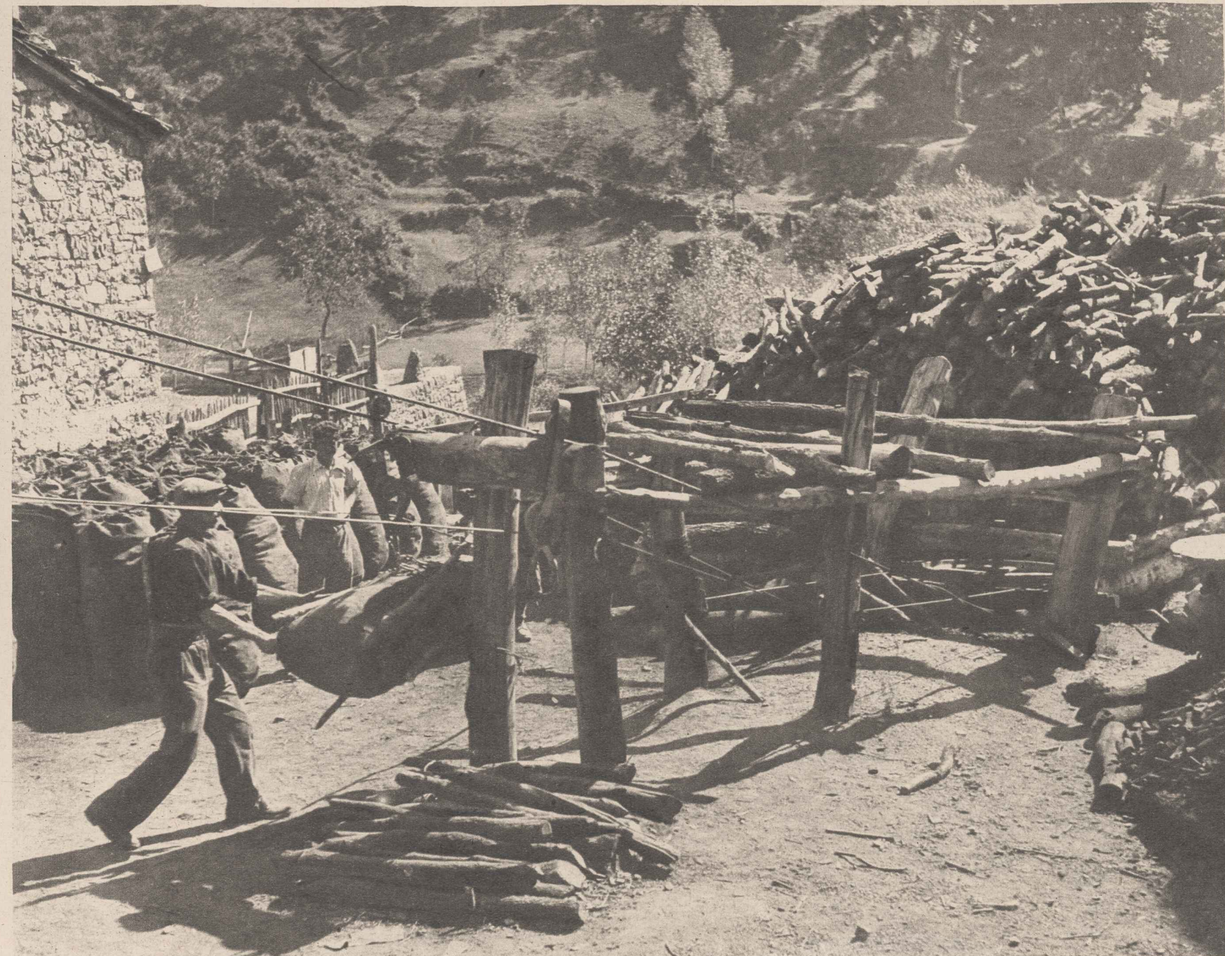
ΕΝΙΟΤΕ οὔτε εἰς τοὺς ἡμιόνους δὲν εἶναι εὐκόλον νὰ φθάνουν εἰς τὰ ξυλανθρακευτικὰ κέντρα. Ὁ ἐναέριος σιδηρόδρομος ἔλυσε τὸ πρόβλημα.
