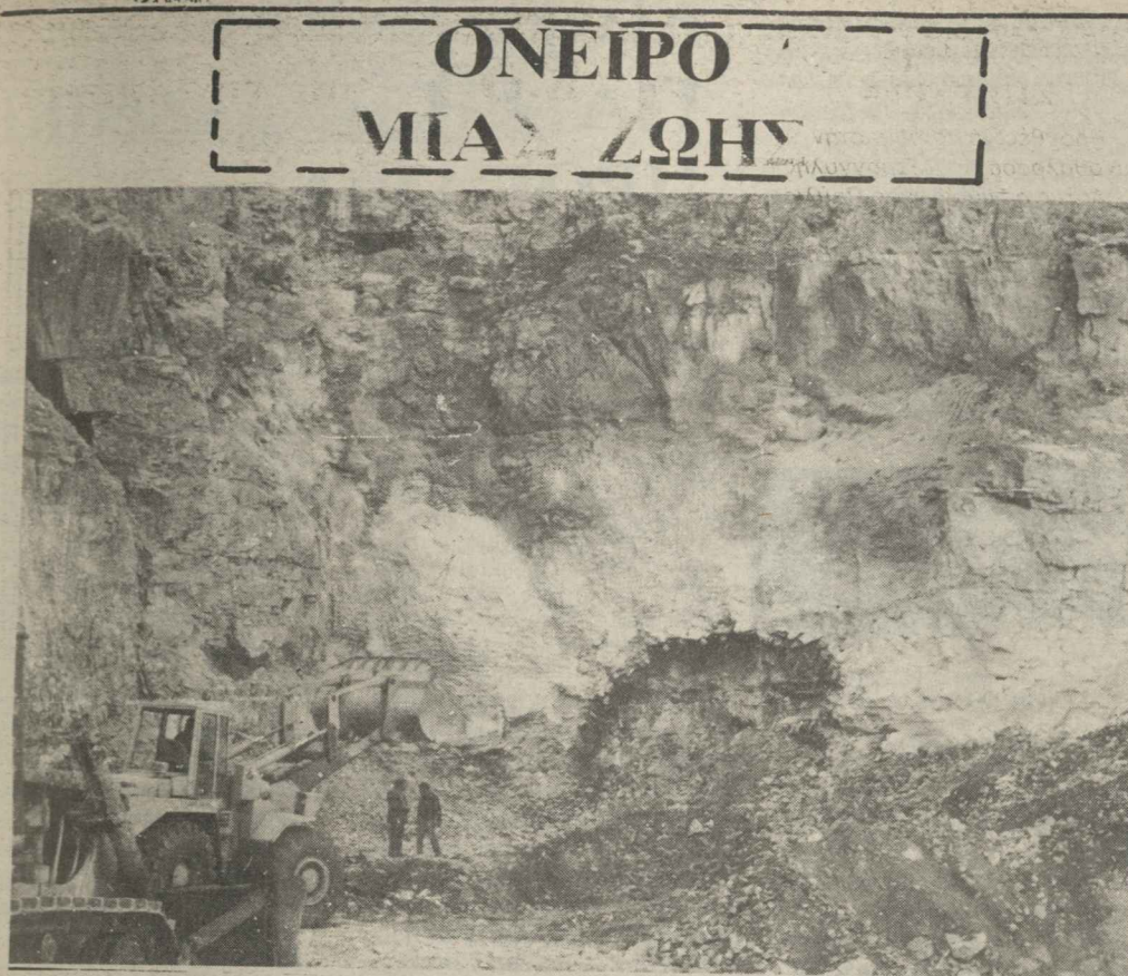
Από την έναρξη των εργασιών διανοίξεως της σήραγγας
