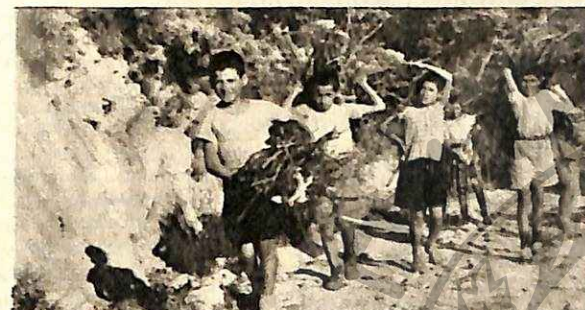
Ε.Σ.Ν. Δημ. Σχολ. Ἀμπελακίου Ρεθύμνης. Μεταφέρουν καυσόξυλα. Juniors of Elem. School Ampelakion Rethymnon, carrying fuel.
