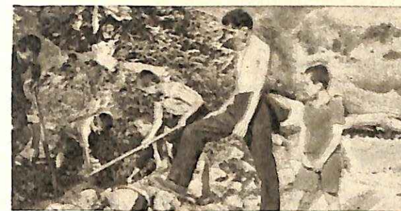
Ε.Σ.Ν. Δημ. Σχολ. Λάκκας Ἡγουμενίτσας. Συνεργάζονται μετ' συγχωριανούς των διὰ κοινοτικά ἔργα. Juniors of Elem. School Lakka Hégoumenitsa helping in community works.
