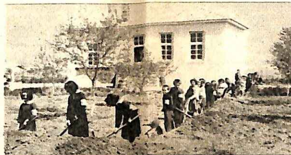
Ε.Σ.Ν. Δημ. Σχολ. Παγουρίου Κομοτινῆς. Διάνοιξις θεμελίων πρὸς ἀνέγερσιν μαδροτοῦχοῦ τοῦ σχολείου. Juniors of Elem. School Pagourion Komotinis laying foundation stones for their playground.
