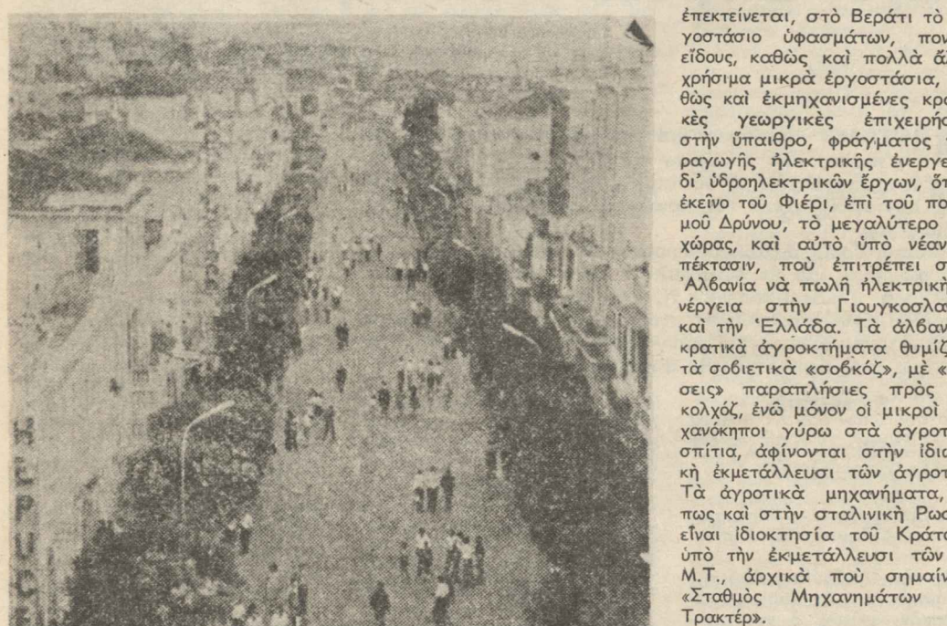
Η κεντρική λεωφόρος περιπάτου σ'ό Δυρράκιο. Σ'ό βάθος διακρίνεται ο λιμνί με κινεζικά φουγάρα.
