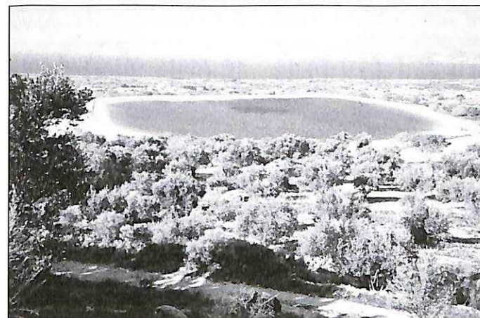
Λιμνοδεξαμενή «ΜΕΣΑΡΙΑΣ» ΑΣΦΕΝΔΙΟΥ, ΚΩ. Χωρητικότητα 200.000 m 3 . Φράγμα υδροληψίας σε υψόμετρο 103 m. Κύρια λιμνοδεξαμενή στα 80m. Διώρυγα προσαγωγής 410 m. μήκος. Τεχνική μελέτη Εταιρεία ΓΚΟΦΑΣ και ΣΥΝΕΡΓΑΤΑΙ. (Φωτογραφία και στοιχεία από τον Βασίλη Βάσσο, Παργινό γεωπόνο στην Κω, τον οποίο και ευχαριστούμε).
