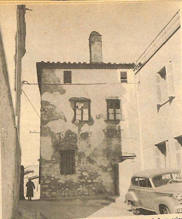
ΤΟ ΣΠΙΤΙ ΤΟΥ ΦΙΝΛΕ-Υ, στὴν ὁδὸν Ἀδριανού, κτίσθηκε γύρω στὰ 1780, πολὺ πρὶν γεννηθῇ ὁ ἱστορικός τῆς Ἐπαναστάσεως τοῦ 21
