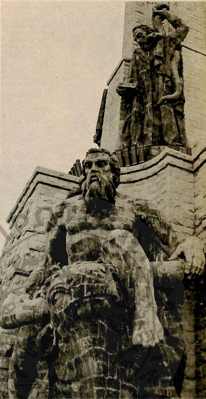
ΟΛΑ ΓΙΓΑΝΤΙΑΙΑ και έπιβλητικά. Άνάμεσα από τα κολοσσιαία αγάλματα, που διακοσμούν τη βάση του πλώριου σταυρού, διακρίνονται οι ηλεκτρικές εγκαταστάσεις, οι οποίες χρησιμεύουν για τη φωταγωγή του.
