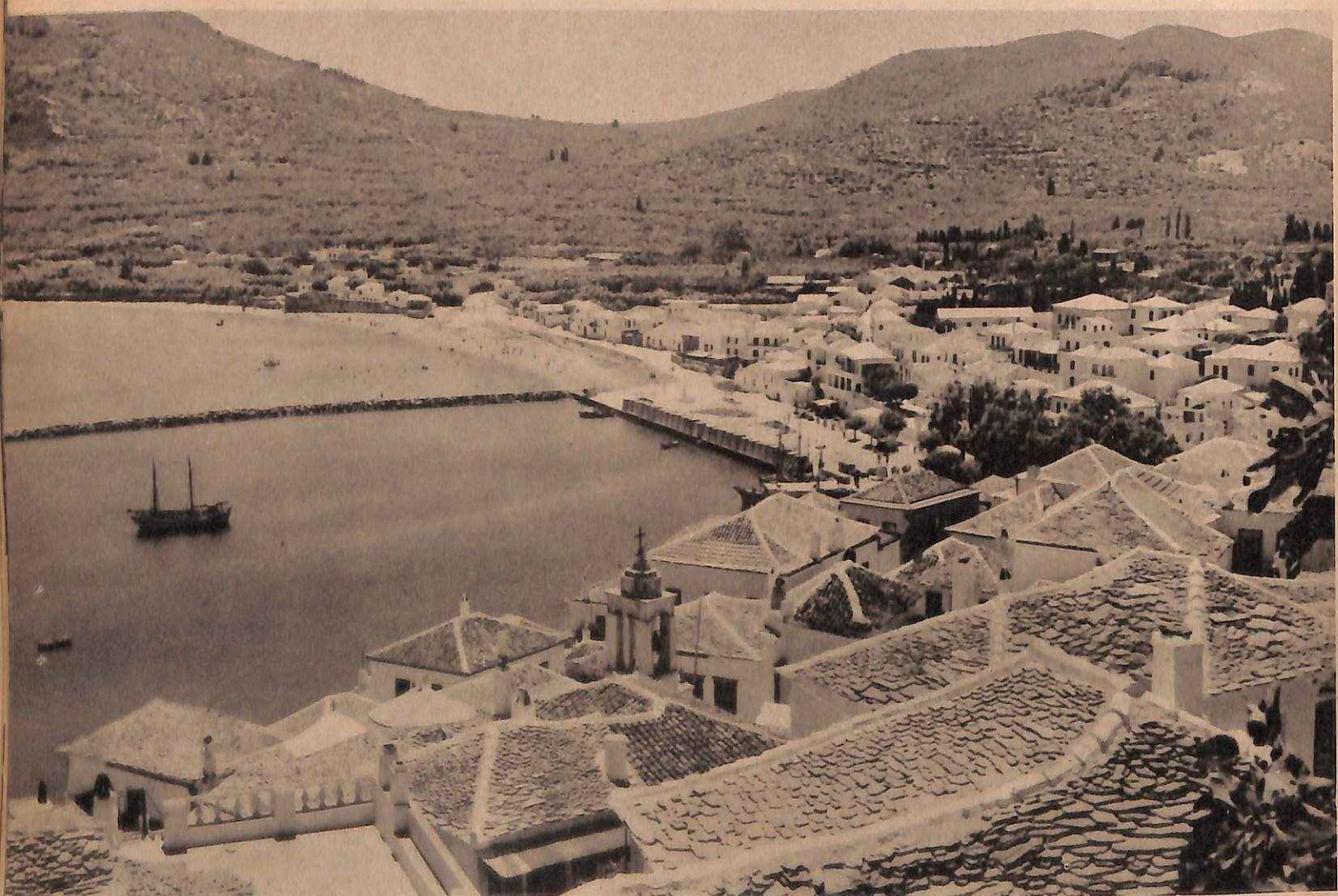
ΗΡΕΜΟ ΤΟ ΛΙΜΑΝΑΚΙ ΤΗΣ ΧΩΡΑΣ. ΕΝΑΣ ΤΕΡΑΣΤΙΟΣ ΛΙΜΕΝΟΒΡΑΧΙΟΝΑΣ ΠΟΥ ΚΑΤΑΣΚΕΥΑΖΕΤΑΙ ΘΑ ΤΟ ΑΣΦΑΛΙΣΗ ΑΠΟ ΤΑ ΒΟΡΙΑ.
