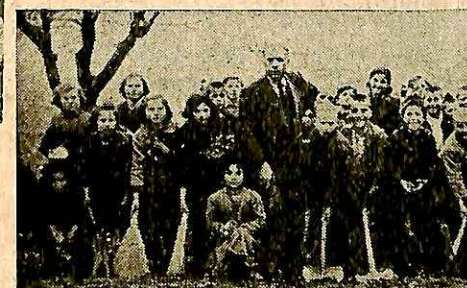
Ε.Σ.Ν. Δημ. Σχολ. Ἀγράφων μεταφέρουν πέτρας διὰ τὴν κατασκευὴν τοῦ σχολείου των.
