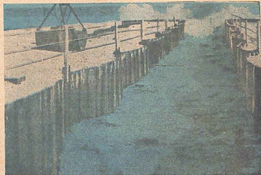
Τὸ εργοστάσιον μετατροπῆς τοῦ θαλασσίου νεροῦ σὲ πόσιμο τῆς Βορείου Καρολίνας. Τὸ θαλάσσιο νερὸ διοχετεύεται ἀπὸ ἕνα μεγάλο φράγμα στὶς εἰδικὲς ἐγκαταστάσεις, ὅπου ὑποβάλλεται στὴν ἀπαιτούμενη ἐπεξεργασία γιὰ νὰ μεταβληθῇ σὲ πόσιμο.
