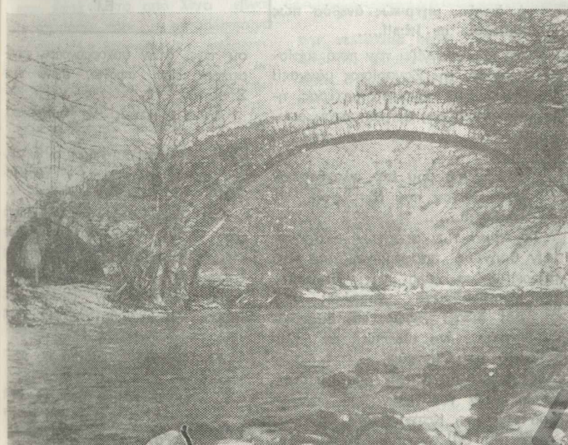
Γέφυρα στον παραπόταμο ΒΑΡΔΑ
