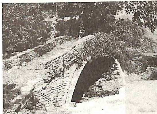
Δόλιανη. Γέφυρα Γκολογκάνη ή Αδαμίδη
