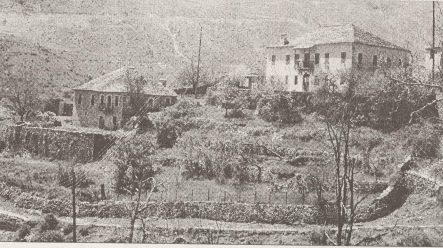
Κάτω δεξιά το σπίτι των αδελφών ΜΠΑΖΑΚΗ, κλασικό δείγμα παραδοσιακής Αρχιτεκτονικής (έτος έκτισεως 1889)
