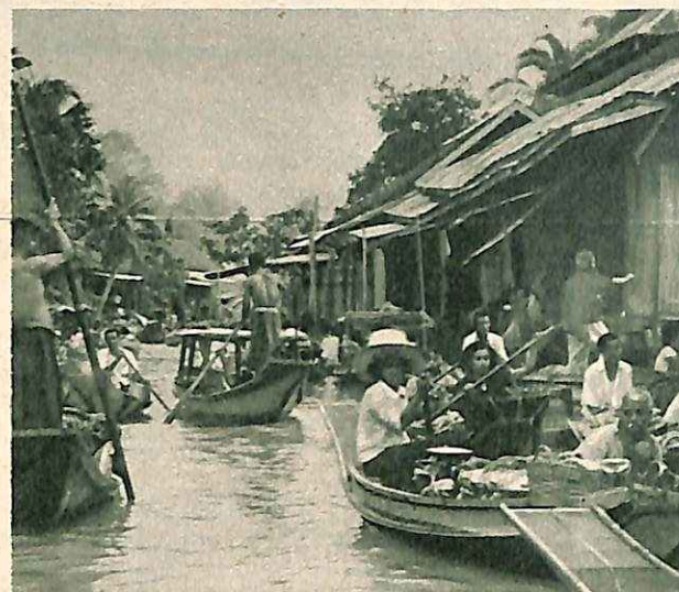
Ένα κανάλι στ' Νότιο Βιετνάμ.
