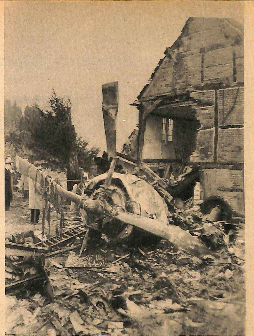
Ο ΕΝΑΣ ΑΠΟ ΤΟΥΣ ΤΕΣΣΕΡΙΣ κινητήρες, καθώς και διάφορα άλλα κομμάτια του αεροπλάνου, κείτονται τώρα μπροστά στο ένα από τα δυο σπίτια του Ντρά-Υ-ΤΟΝ, που σωριάστηκαν σε έρείπια από τη σύγκρουση,
