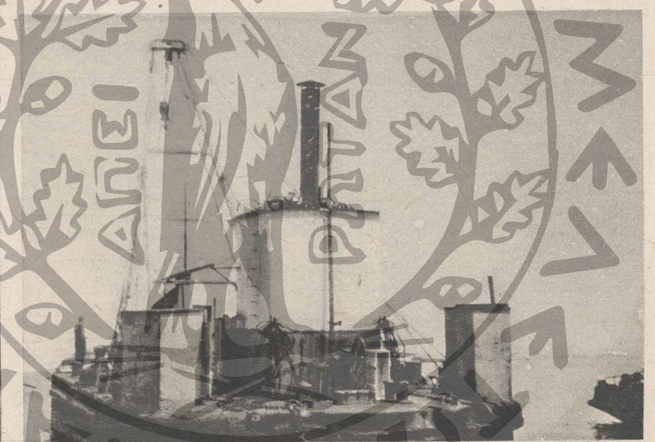
4 Η ΠΛΩΤΗ ΓΕΟΥΡΑ ΕΧΕΙ ΜΙΑ ΕΠΙΜΗΚΗ ΜΕΤΑΛΛΙΚΗ ΟΥΡΑ. ΤΗΝ ΡΥΜΩΚΕΙ ΕΝΑ ΑΤΜΟΚΙΝΗΤΟΝ ΠΛΟΙΑΡΙΟΝ. ΤΗΝ ΒΛΕΠΟΜΕΝ ΕΔΩ ΝΑ ΠΡΟΧΩΡΗ ΠΡΟΣ ΤΟ ΜΕΡΟΣ ΟΠΟΥ ΠΡΕΠΕΙ ΝΑ ΣΤΡΩΘΗ ΤΟ ΔΙΚΤΥΟΝ ΔΙΑ ΝΑ ΚΛΕΙΣΗ ΚΑΙ ΝΑ ΚΑΤΑΣΤΗΝ ΤΟΙΟΥΤΟΤΡΩΠΩΣ ΑΠΡΟΣΙΤΑ ΤΑ ΥΔΑΤΑ ΑΠΟ ΚΑΘΕ ΕΧΘΡΙΚΗΝ ΠΑΡΑΒΑΣΙΝ. ΑΚΟΛΟΥΘΕΙ
