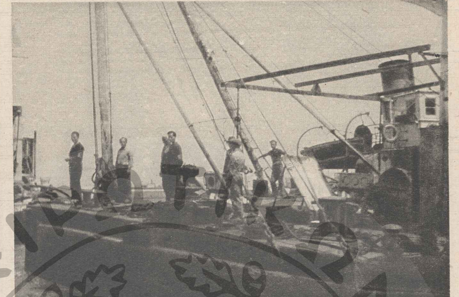
3 ΟΤΑΝ ΤΑ ΔΙΚΤΥΑ, ΑΦΟΥ ΓΙΝΗ ΤΟ ΤΥΛΙΓΜΑ ΤΩΝ, ΜΕΤΑΒΑΛΟΥΝ ΕΙΣ ΚΥΛΙΝΔΡΟΥΣ ΠΟΥ ΘΥΜΙΖΟΥΝ ΤΑ ΕΠΙΜΗΚΗ ΛΟΥΚΑΝΙΚΑ, ΤΟΠΟΘΕΤΟΥΝΤΑΙ ΕΠΑΝΟ ΣΕ ΜΙΑ ΓΥΡΗ ΕΠΙΦΑΝΕΙΑ ΚΑΙ ΑΦΙΝΟΝΤΑΙ ΝΑ ΓΑΥΣΤΡΗΘΟΥΝ ΣΤΗ ΘΑΛΑΣΣΙΑ ΜΕ ΤΗ ΒΟΗΘΕΙΑ ΤΩΝ ΓΕΡΑΝΩΝ ΚΑΙ ΤΩΝ ΒΑΡΟΥΛΑΚΩΝ ΠΟΥ ΒΡΙΣΚΟΝΤΑΙ ΣΤΟ ΚΑΤΑΣΤΡΩΜΑ.
