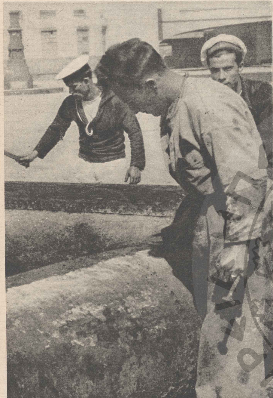
1 ΑΠΟ ΚΑΙΡΟΥ ΕΙΣ ΚΑΙΡΟΝ ΜΕΤΑΦΕΡΟΥΝ ΤΙΣ ΣΗΜΑΔΟΤΕΣ ΕΙΣ ΤΗΝ ΉΞΑΝ ΔΙΑ ΝΑ ΚΑΘΑΡΙΣΘΟΥΝ ΑΠΟ ΤΟ ΠΕΡΙΒΑΛΛΟΝ ΤΩΝ ΑΚΑΘΑΡΣΙΩΝ, ΠΟΥ ΑΦΙΝΟΥΝ ΕΠΑΝΟ ΕΙΣ ΤΑ ΜΕΤΑΛΛΑΝ ΤΑ ΘΑΛΑΣΣΙΑ ΦΥΤΑ. ΠΡΩΤΑ ΚΤΥΠΟΥΝ ΚΑΘΕ ΚΥΛΙΝΔΡΟΝ ΚΑΙ ΎΣΤΕΡΑ ΤΟΝ ΒΟΥΤΥΡΙΖΟΥΝ ΟΠΩΣ ΕΝΑ ΖΕΥΓΑΡΙ ΥΠΟΔΗΜΑΤΑ ΔΕ ΠΟΥ ΝΑ ΚΑΘΑΡΙΣΗ.
