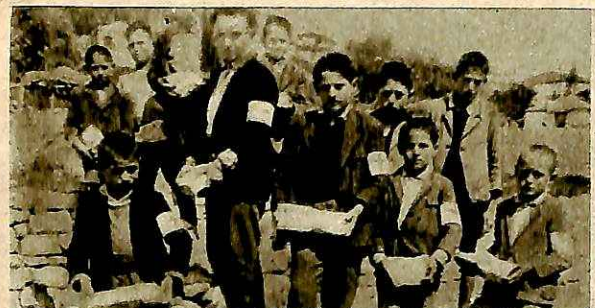
Ε.Ε.Σ.Ν. Δημ. Σχολ. Νεοχωρίου Παραμυθίας. Περιτοίχισις τοῦ σχολικοῦ χώρου. Juniors of Elem. School Neochorion. Paramythia. Surrounding with walls the school space.
