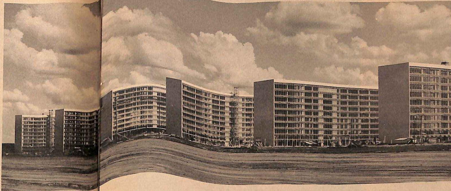
ΠΟΛΥΩΡΟΦΑ κτίρια, πού ξεφύτρωσαν σάν μανιτάρια μέσα στην έρημο, μέσα σέ μερικές έβδομάδες, συγκροτούν τό διοικητικό κέντρο. Ήδη έγκατεστάθησαν σ' αυτά οι πρώτοι 3.000 ύπάλληλοι. Άλλά ή μεταφορά τών πολυαριθμών ύπηρεσιών της διοίκησης θα γίνει, δέβαια, σταδιακάς
