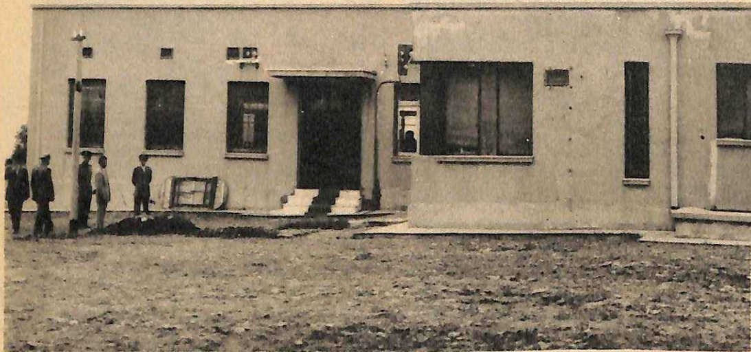
ΣΤΗ ΒΑΡΗ, ΤΟ ΚΤΙΡΙΟ ΠΟΥ ΣΤΕΓΑΖΕΙ ΤΟ ΣΤΑΘΜΟ ΕΠΙΚΟΙΝΩΝΙΑΣ ΒΡΑΧΕΩΝ ΚΥΜΑΤΩΝ
