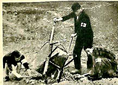
ΕΕΝ δημ. Σχ. Δεσποτικού Πωγωνίου επισκευάζουν την άμαξιτην οδόν. Juniors of Elem. School Despotikon repairing the high way.
