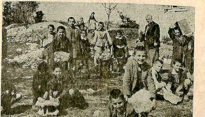
ΕΕΝ Δημ. Σχολ. Καρίτσας μεταφέρουν ύλικά διά την έπισκευήν του Γυμναστηρίου. Juniors of Elem. School Karitsa helping in the reconstruction.
