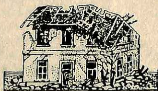
Σεισμικά βλάβαι 10ου—12ου βαθμού επί κοινών πλινθοδομών.
